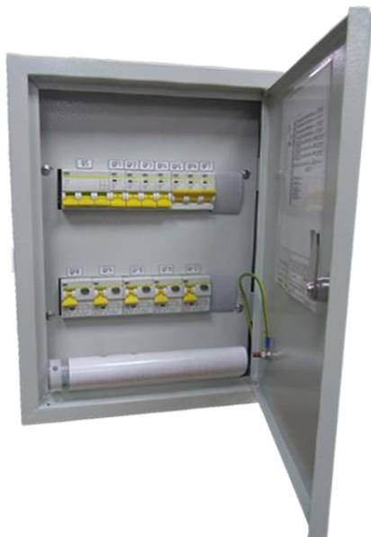
Щиты групповые распределительные предназначены для приема и распределения электрической энергии напряжением 400/230В трехфазного переменного тока частоты 50Гц с глухозаземленной нейтралью, а также для нечастых (не более 6-ти в час) коммутаций и защиты однофазных отходящих линий от перегрузок и токов короткого замыкания.
