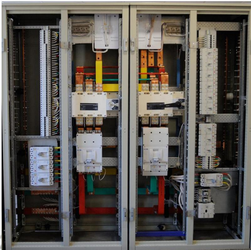
Устройство вводно-распределительное УВР (ГРЩ, ВРП) предназначено (в зависимости от типа панели) для приема, распределения и учета электрической энергии трёхфазного переменного тока напряжением 380/220В частоты 50Гц, а также для защиты линий от перегрузок и токов короткого замыкания.
